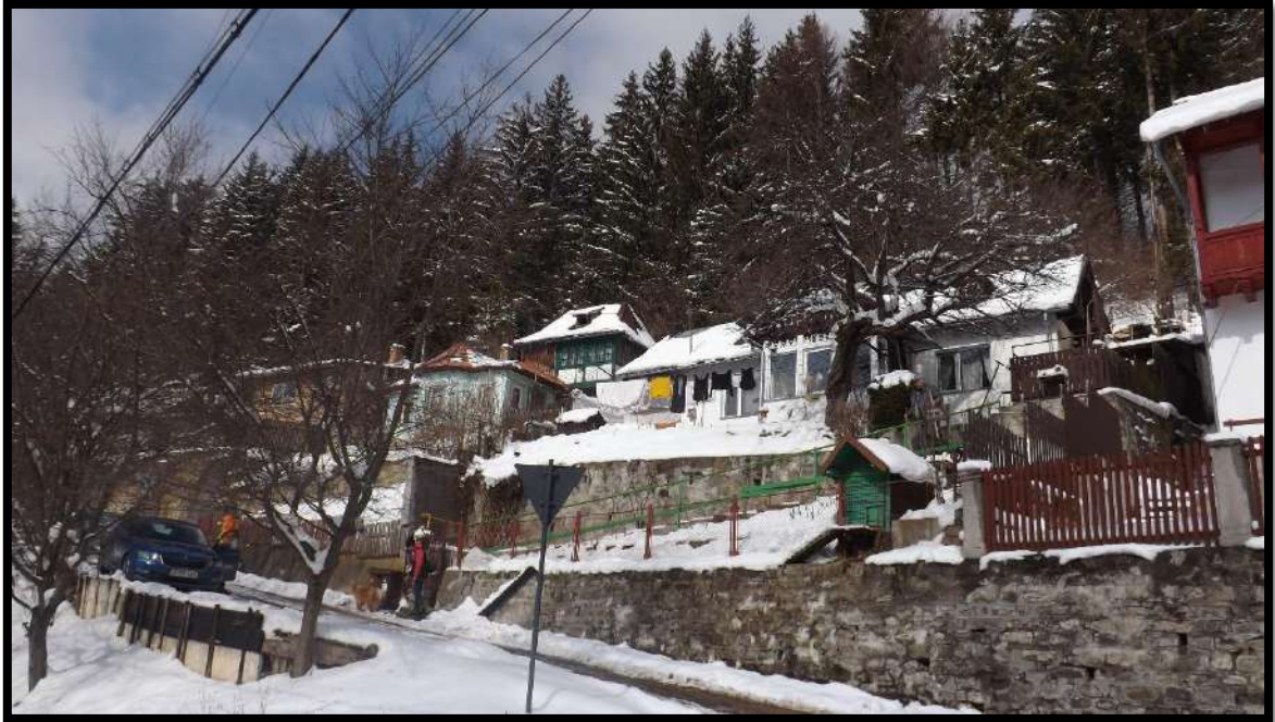
Str. Clăbucet, colț cu str. Parcului – consolidări în trepte în zona capătului de est
