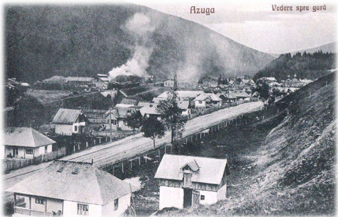
Azuga, post 1903 (biserica fost ridicată) cu casele Zangoreștilor în prim plan – se observă arhitectura rurală vernaculară ( https://imageromania.ro/ )
