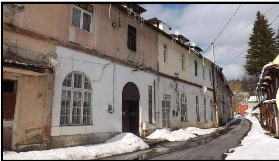
Grupul de clădiri desfășurat de-a lungul str. Postăvăriei în martie 2022
