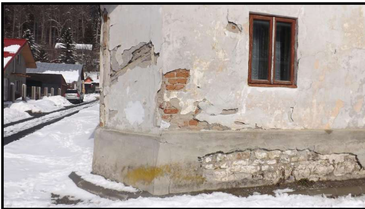
Str. Vânători, nr. 2 – starea de conservare îngăduie să se observe detaliat tehnica de construcție mixtă
