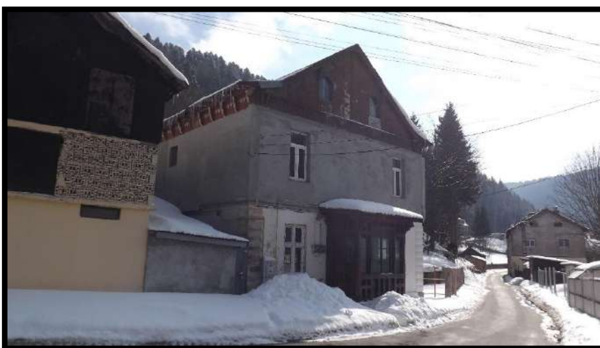
Băile fabricii de postav în martie 2022
