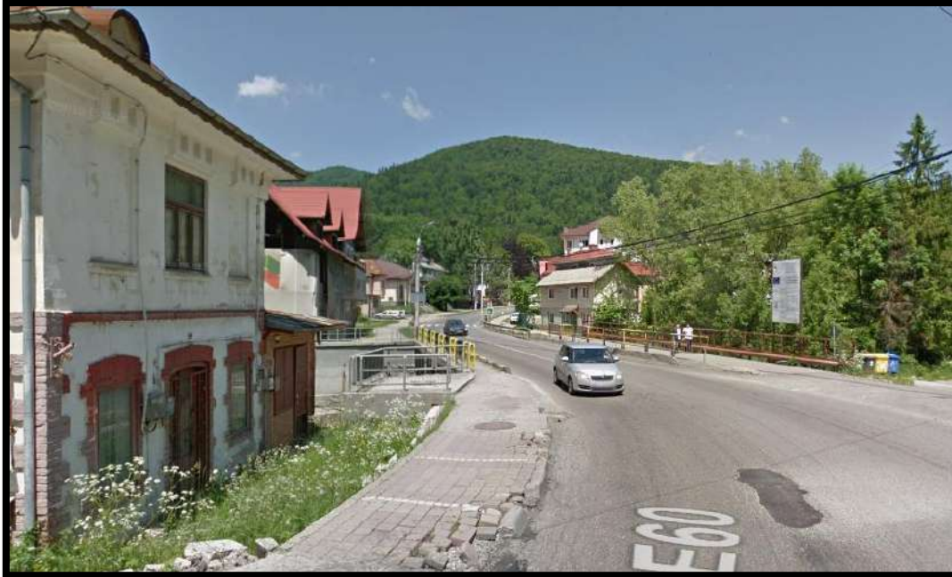
Podul principal de peste Azuga la începutul secolului XX (imageromania.ro) și în 2019 (www.google.com/maps). Între timp și latura din stânga a primit o pasarelă metalică pentru tranzitul pietonal.
