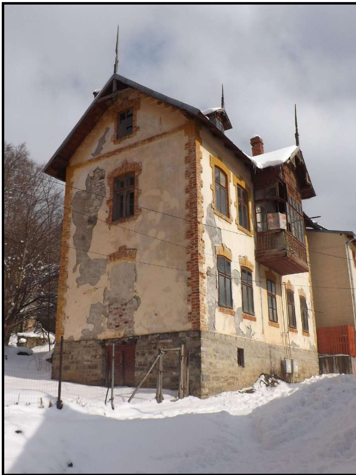
Imediat lângă casa anterior prezentată, imobilul de pe str. Muncii, de la nr. 5, ca și vecinul său de la nr.7, prezintă o întoarcere la arhitectura în stil urban-industrial, completată însă cu decor traforat
