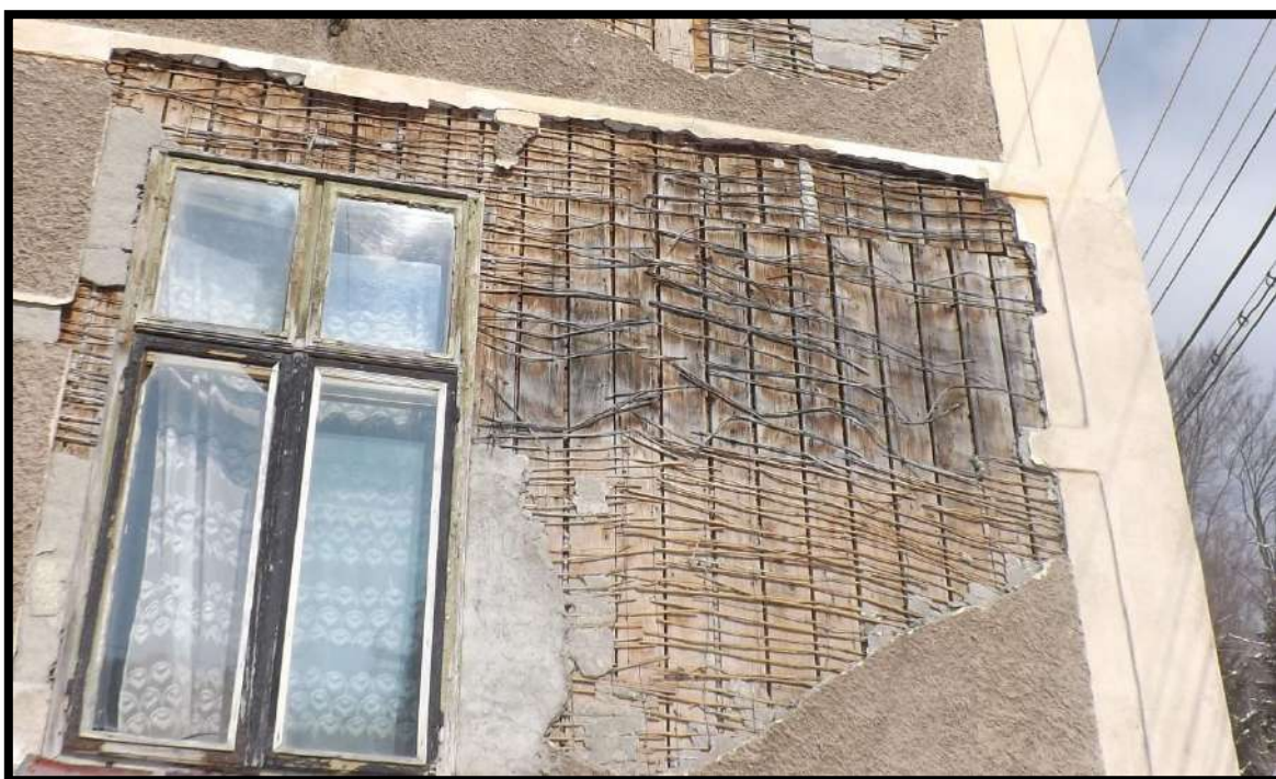
Str. Muncii, nr.5 văzut din spate, prezentând încă și mai mult decor traforat de lemn (sus) și detaliu cu izolație termină de lemn a imobilului de pe str. Muncii, nr.7
