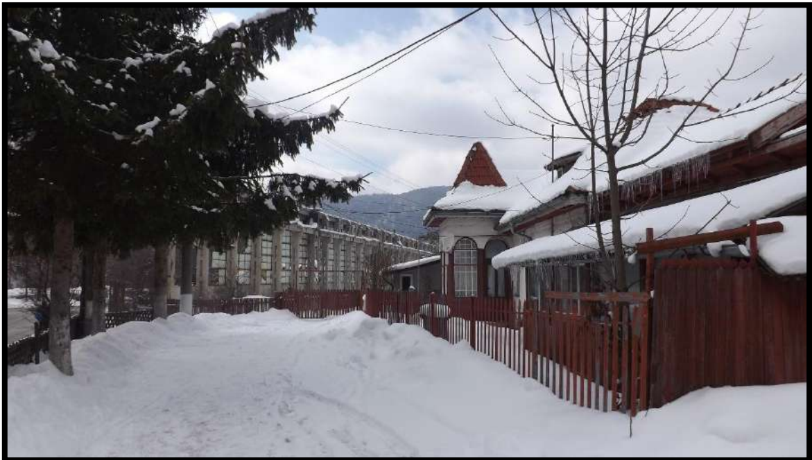
Str. Ritivoiu, nr.1, în stil cu influențe romantice, unul dintre rarissimele obiective cu valoare arhitecturală din „orașul nou” de la est de fosta fabrică de ciment (șamotă) ale cărei ruine se pot observa în fundal
