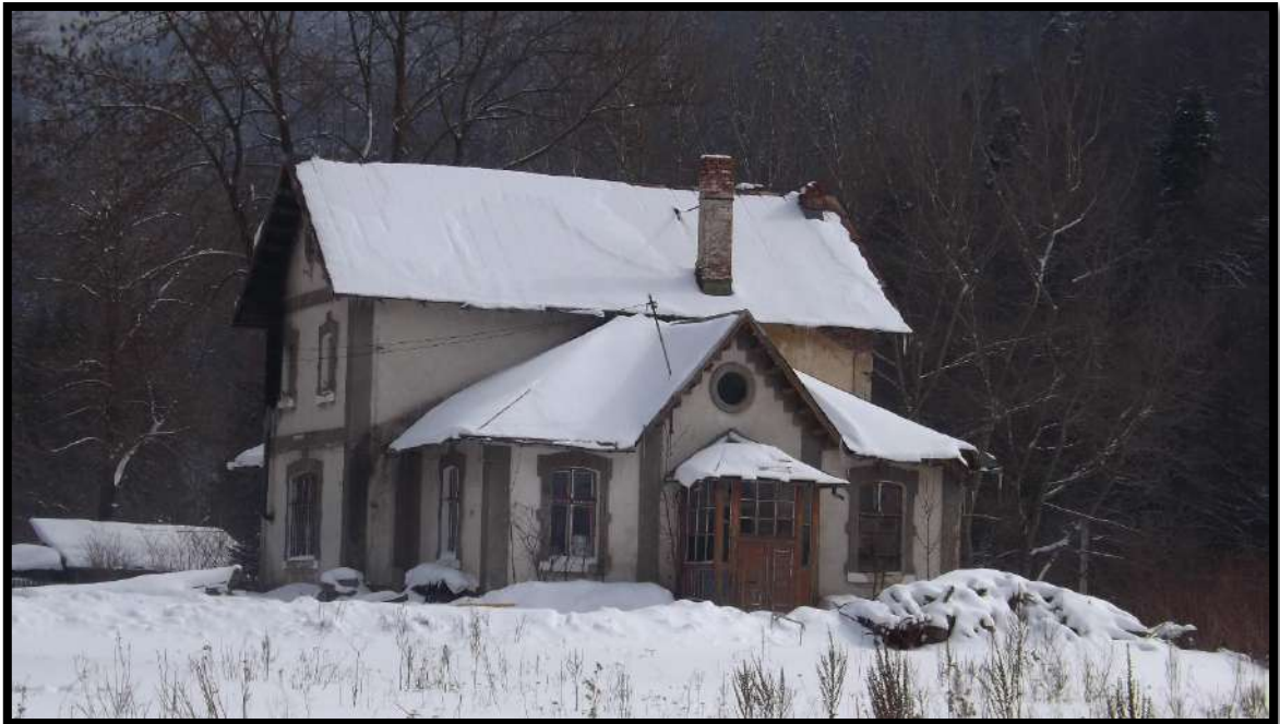
Variante ale stilului urban-industrial pe str. Independenței (nr.14/20 și nr.20), la structuri anterior în conexiune cu fabrica de bere
