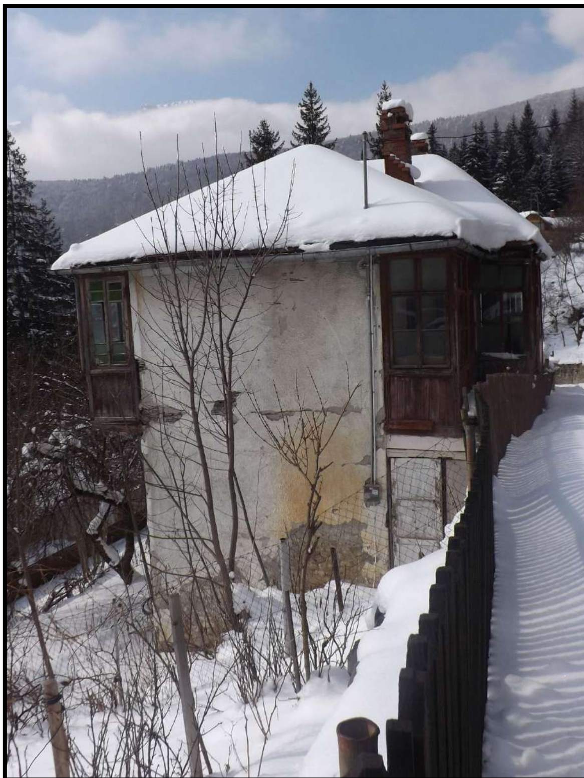
Str. Parcului nr.4 – vedere laterală
