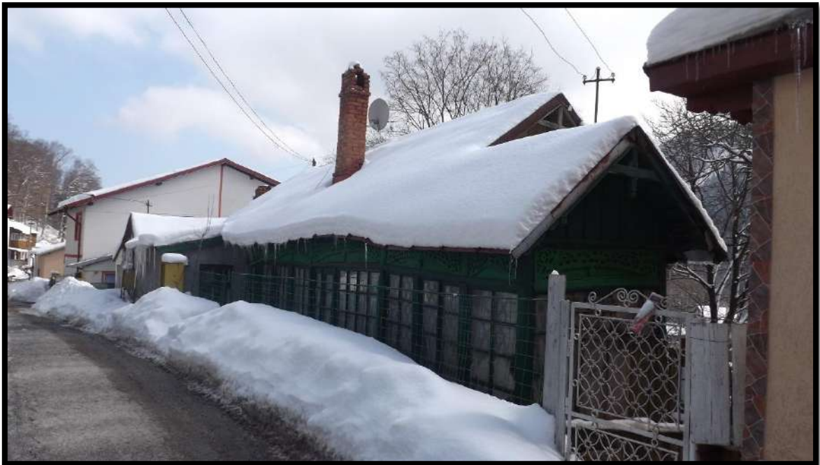
Str. Parcului, nr. 4 și nr.16 – construcțiile de pe frontul sudic al străzii sunt ridicate în buza pantei
